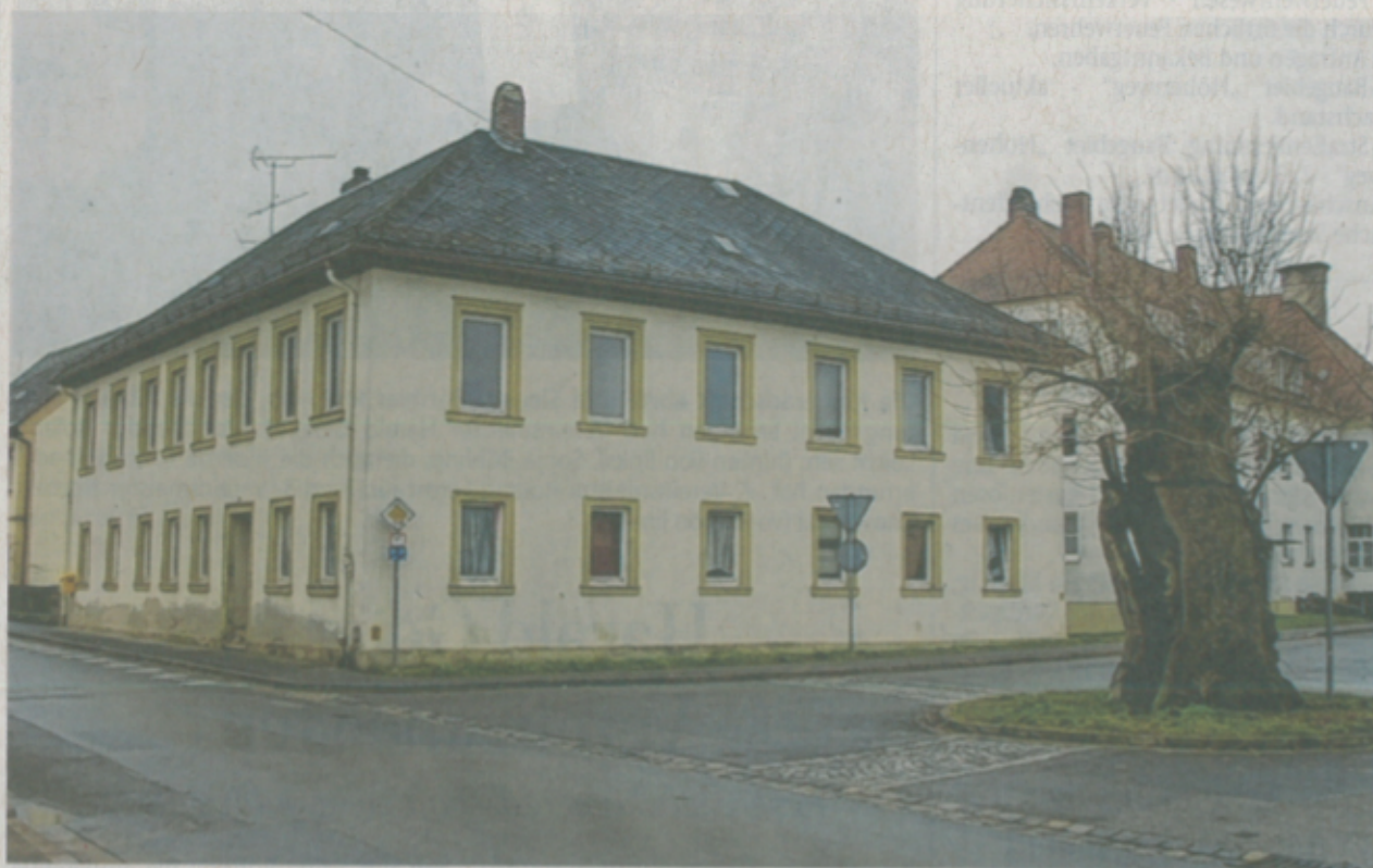
Abriss und Neubau: An der Ecke Kreuzberg/Viktor-von-Scheffel-Straße sollen Familien, Menschen mit Behinderungen, Demenzkranke und Obdachlose Wohnraum finden.
