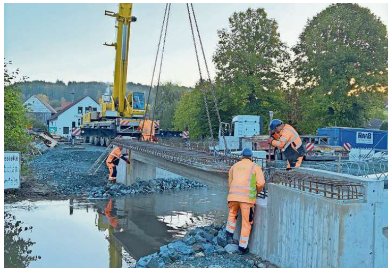
Die Bauarbeiten für die neue Brücke über die Wiesent in Wadendorf laufen. In dieser Woche wurden die fünf rund 50 Tonnen schweren Brückenfertigteile installiert.
