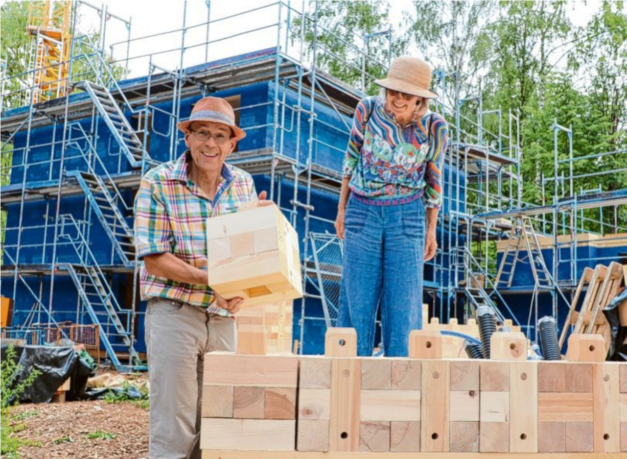
„Das ist ja wie Lego“: Die beiden Genossen Gerhard und Imma aus München erkunden die Baustelle. Großes Interesse ziehen die Massivholzbausteine auf sich. Fotos: Annette Körber
