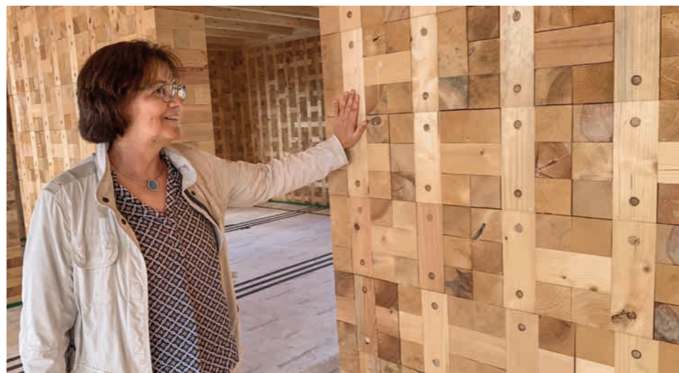
Im Vorfeld des Redwitzer Projektes „Kleiner Wohnen @ Land“ laufen bei Raab Bau Testversuche mit unterschiedlichen, nachhaltigen Baumaterialien wie Holzbausteinen und Lehm. Foto: Raab Bau
