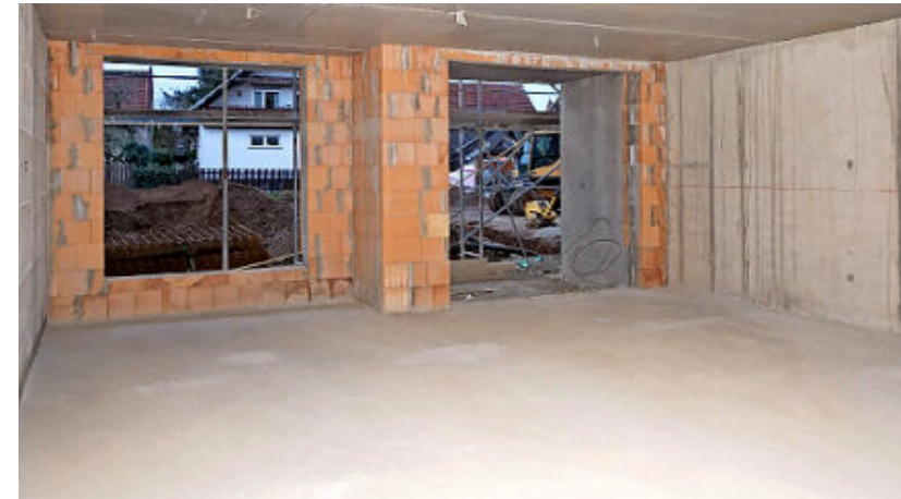
Blick in eines der fast fertigen Appartements
