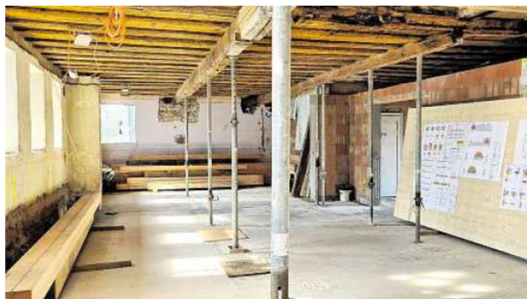
So sieht es gerade auf der Baustelle des Gemeinschaftshauses Döringstadt aus.
