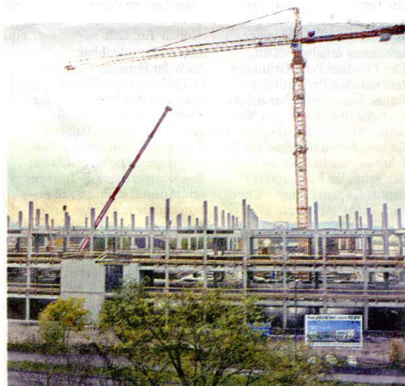
Dank Fertigbauteilen wächst die neue „städtebauliche Dominante“ am Berliner Ring mit hoher Geschwindigkeit. Schon Anfang 2008 ist Teil-Eröffnung des neuen Pilipp-Möbelhauses. Foto: Matthias Hoch
