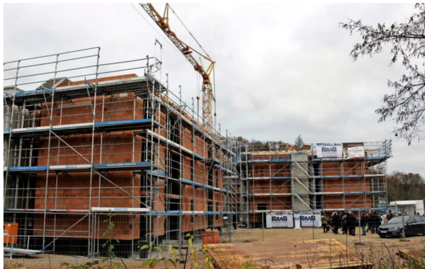
Nach nur sechs Monaten Bauzeit schmückt der Richtbaum die Seniorenwohnanlage „Am Seeanger“ in Frensdorf.
