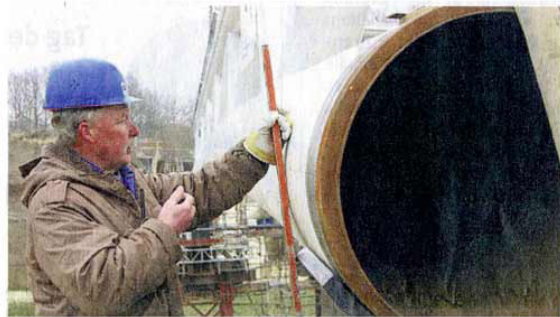
Josef Kerscher prüft mit einer Wasserwaage, ob die Position stimmt.
