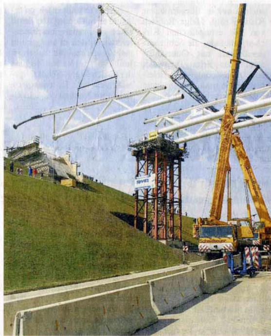
Am Nachmittag, gegen 14 Uhr, wurde das erste der vier Seitenteile eingehoben.
