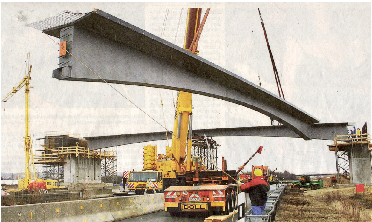
500 Tonnen Maximallast: Es dauerte mehr als zwei Stunden, um den 100 Tonnen schweren Autokran zu installieren.
