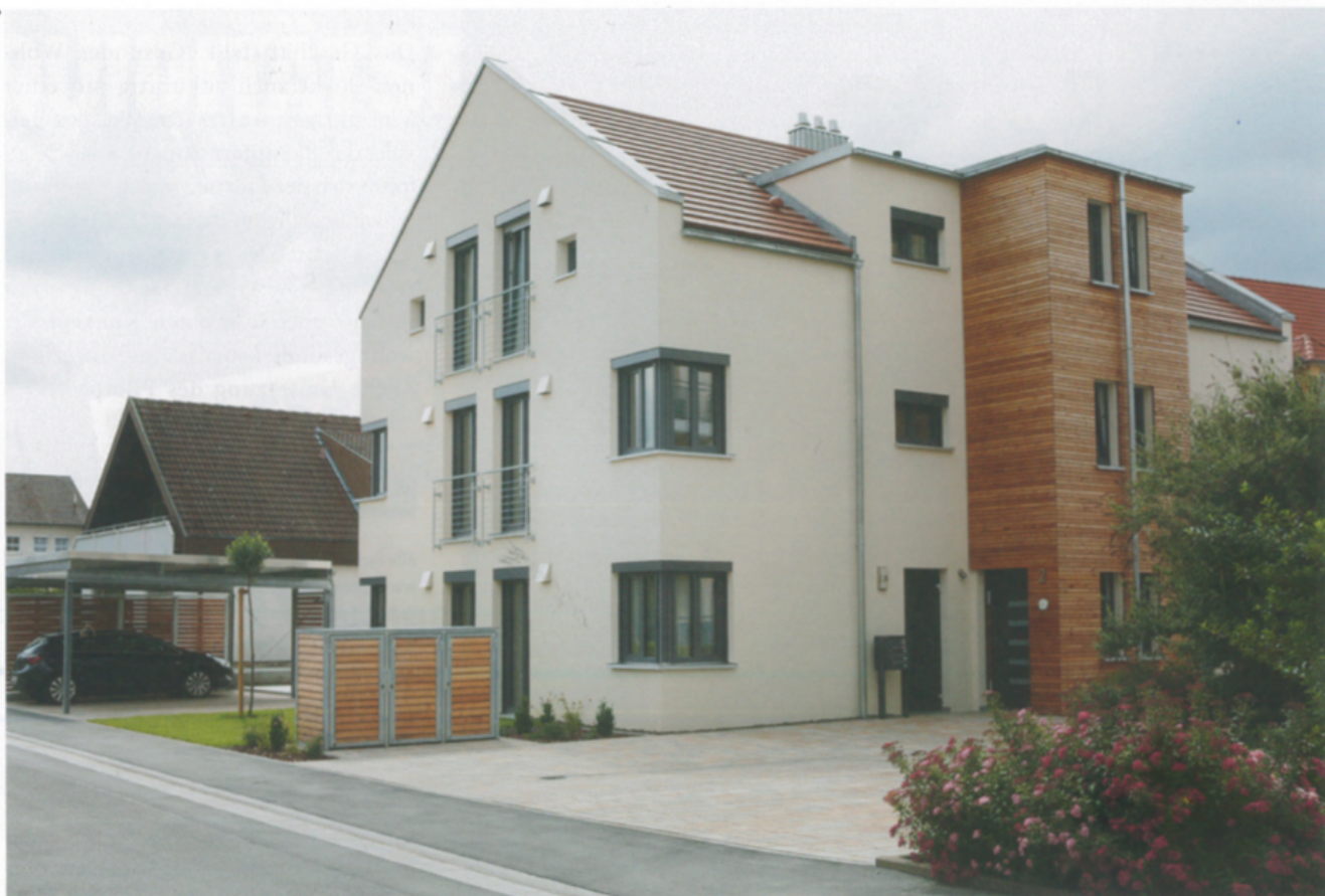
Dank der guten Dämmwerte des eingesetzten Poroton-Ziegels konnte auf zusätzliche Schichten an der Fassade verzichtet werden.
