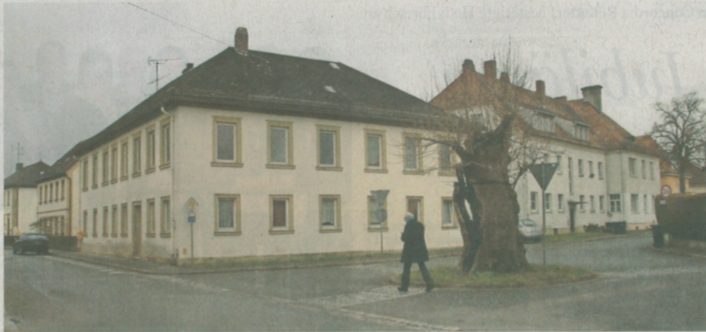
Diese Häuser am Staffelsteiner Kreuzberg, die Eigentum der Stadt sind, werden abgerissen. An dieser Stelle wird ein Gebäudekomplex errichtet, der sowohl Eigentums- und Mietwohnungen für Familien und Senioren als auch Räume für eine Wohngruppe dementer Menschen umfasst.
