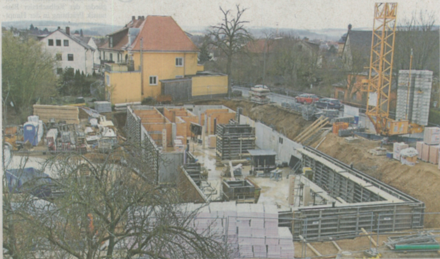
Die Fundamente sind gegossen, der Grundstein ist gelegt. Nun können die beiden Gebäude an der Ecke Viktor-von-Scheffel-Straße/Am Kreuzberg in die Höhe wachsen. Im Sommer 2016 sollen die Wohnungen bezugsfertig sein.
