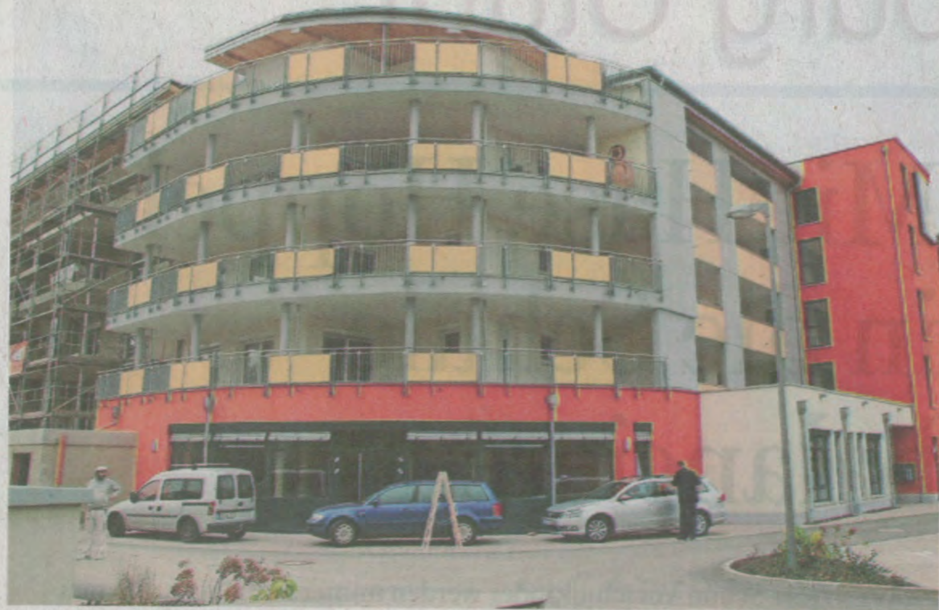
Der riesige Gebäudekomplex in der Cortendorfer Straße nimmt immer mehr Gestalt an.
