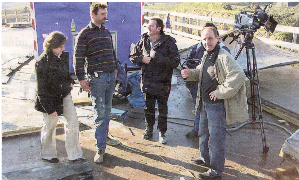
Gisela Raab (von links) und Stefan Schubert von der Ebensfelder Baufirma Raab mit dem WDR-Filmteam auf einer Baustelle.
