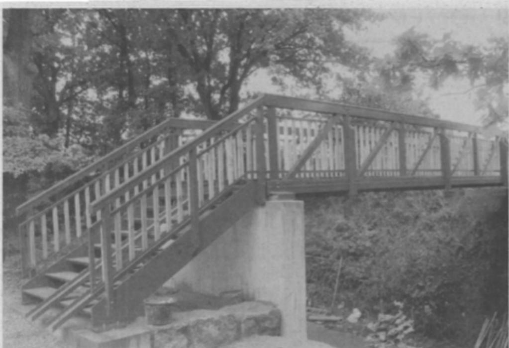
Die Aluminiumbrücken werden im Werk der Glück GmbH in Engen-Welschingen fertig zusammengebaut und am Stück an den Montage-Ort geliefert. Dies ermöglicht eine schnelle Montage vor Ort.
