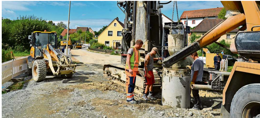
Der letzte Bohrpfahl wird unter den Augen von Polier Peter Büttner gesetzt.
