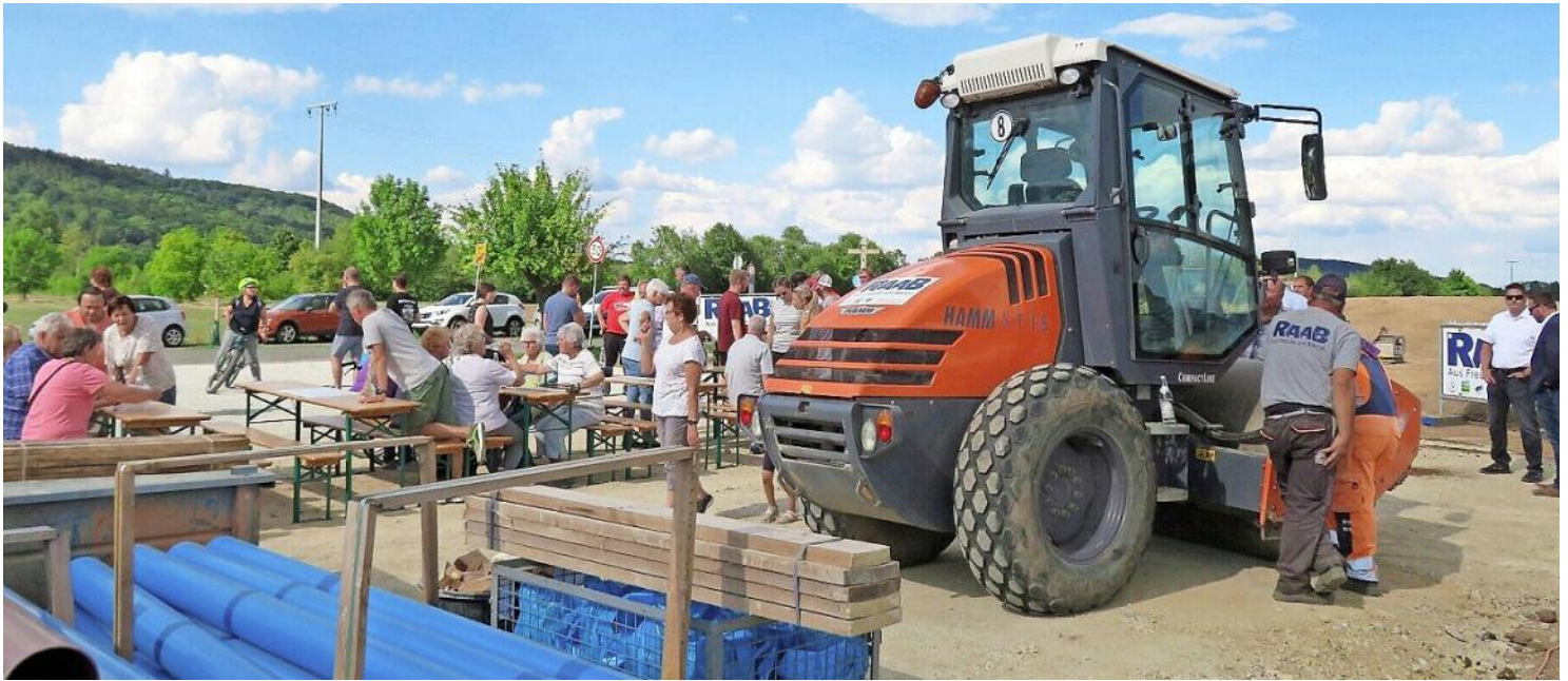
Bürgermeister Mario Schönwald (ganz rechts im Bild) unterhält sich mit Ortschaftspracher Christian Ziegler beim Spatenstich. Die Schönbrunner feierten derweil ihr neues Baugebiet mit Getränken und einem Imbiss.
