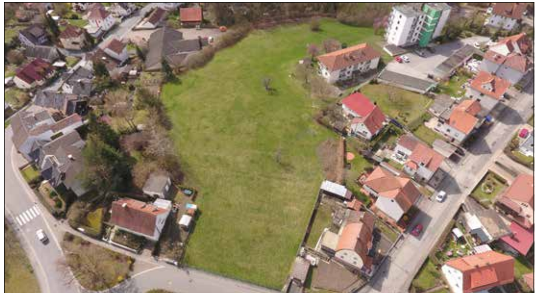
Auf dem Foto ist die Fläche aus Sicht der Wüstenahorner Straße zu sehen, die Freifläche befindet sich hinter dem ehemaligen Lebensmittelmarkt mitten im Hauptort Ahorn. Der Baubeginn ist für Mitte/Ende 2023 geplant. Foto: Baugesellschaft Raab GmbH
