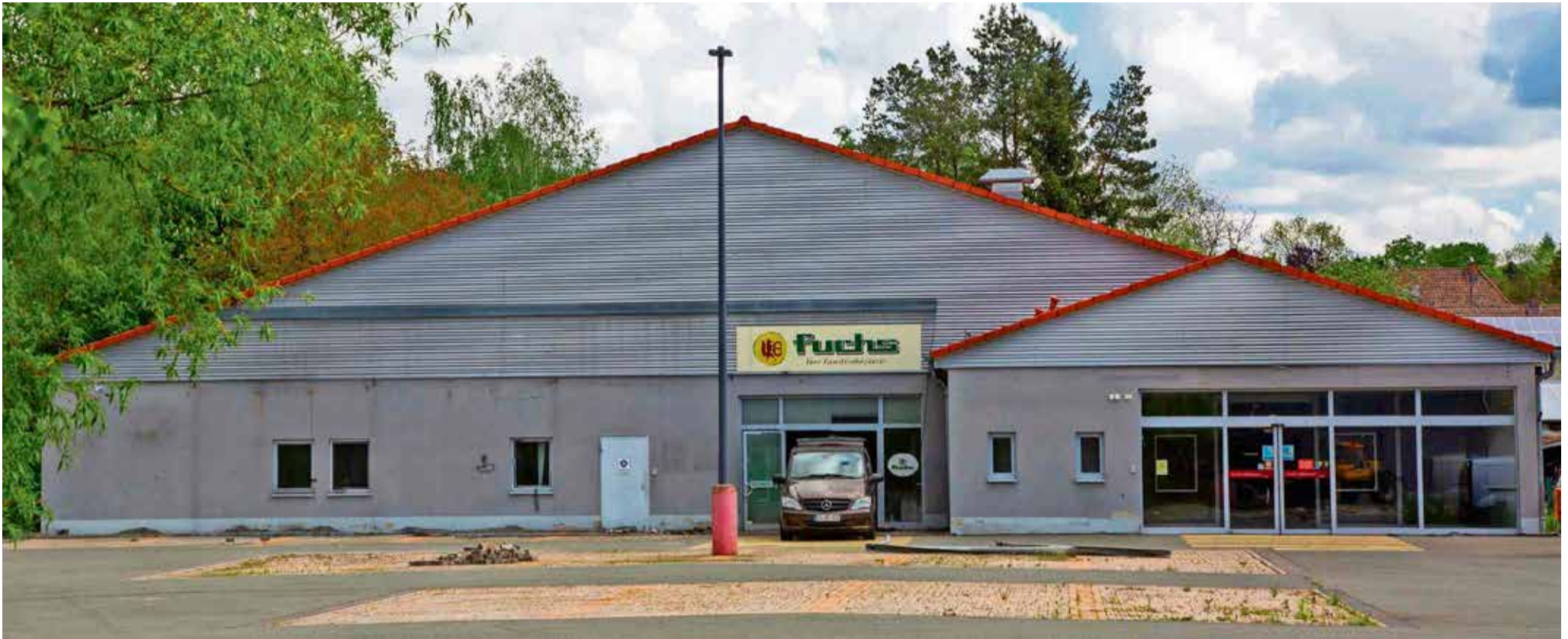
Ein Supermarkt sowie ein Getränkemarkt weichen in Mönchröden den Plänen für seniorengerechtes Wohnen. Doch vorher wurde alles, was irgendwie geht, wiederverwendet. Foto: Karsten Schöne/Raab
