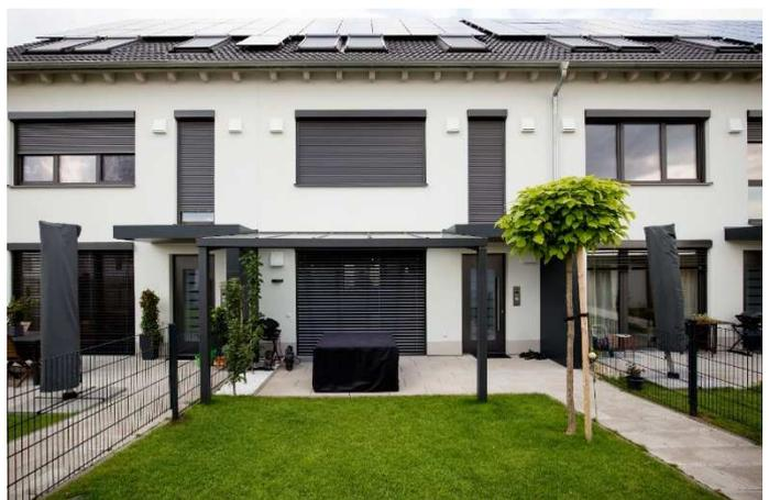
Für die Außenwände kamen hochwärmegedämmte Poroton-Ziegel der Firma Schlagmann Poroton zum Einsatz. Foto: CHURU
