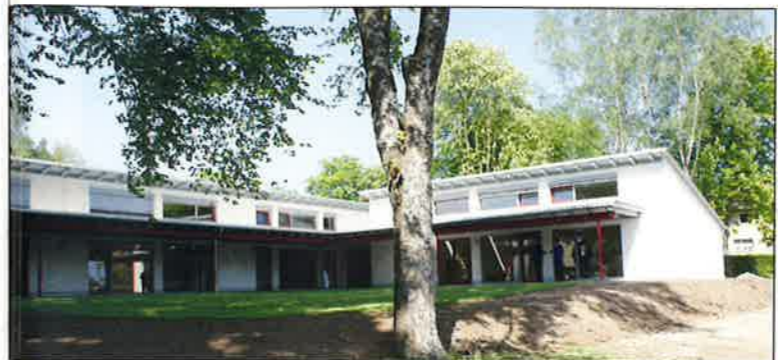
Die neue Fritz-Anke-Kita in Rödental. Sie bietet den Kleinen viele Möglichkeiten, im Inneren des Gebäudes ebenso wie im Freien
