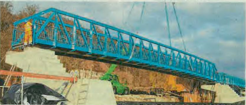
Geschafft: Die Brücke liegt auf den Betonfundamenten.
