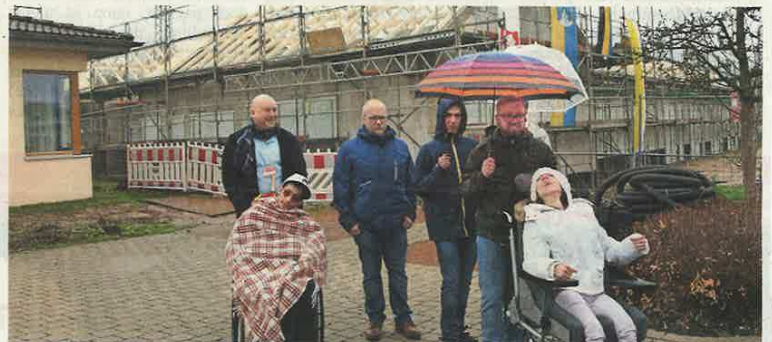
Auch Klienten der Fördergruppe wohnten dem Richtfest bei und freuten sich über den Baufortschritt.
