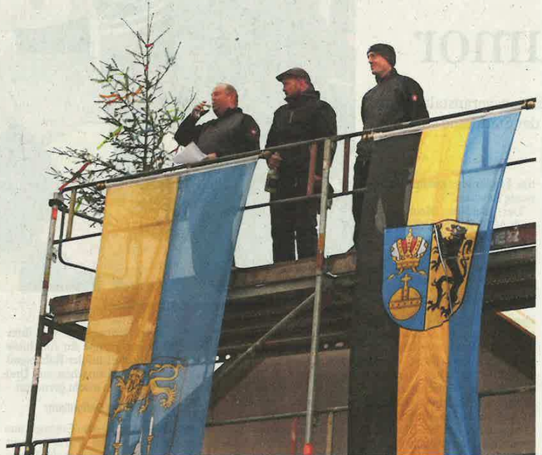
Ein Mitarbeiter der Zimmerei Holzbau Thiel sprach den Richtspruch und ließ den Bauherrn, die Gäste und die am Bau beteiligten Handwerker hochleben.
