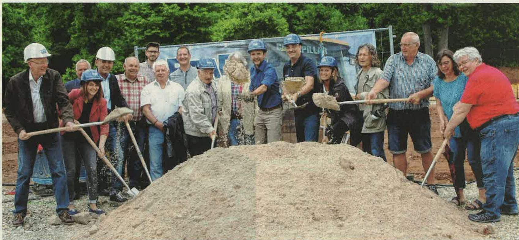
Bürgermeister Andreas Hügerich, der Leiter der Stadtwerke Dietmar Weiß, die Vertreter der beteiligten Firmen und viele Stadträte gaben mit dem ersten Spatenstich den Start zum Neubau der Stadtwerke frei.
