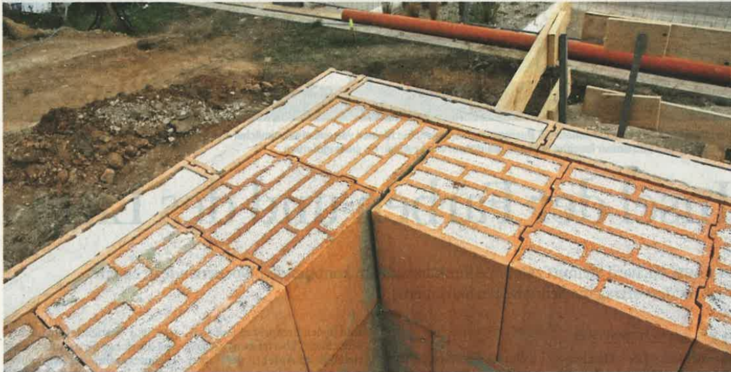
Mit dem Vulkangestein Perlit gefüllte Mauerwerksteine auf einer Baustelle. Diese Wand braucht keine zusätzlich Dämmung mehr.
