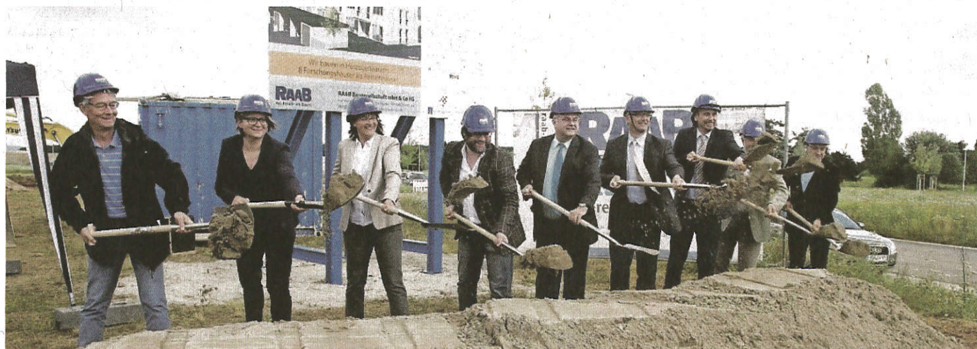
Der erste Spatenstich ist getan, jetzt können die Bagger anrücken.
