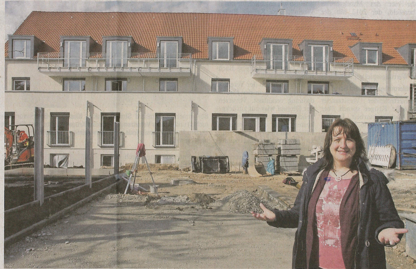
Martina Lutter vom Caritas-Kreisverband auf der Staffelsteiner Großbaustelle an der Ecke Victor-von-Scheffel-Straße/Am Kreuzberg. In den Räumen hinter der grauen Betonwand entstehen derzeit die Räume der ersten Senioren-WG für Demenzkranke im Landkreis. Foto: Andreas Schmitt
