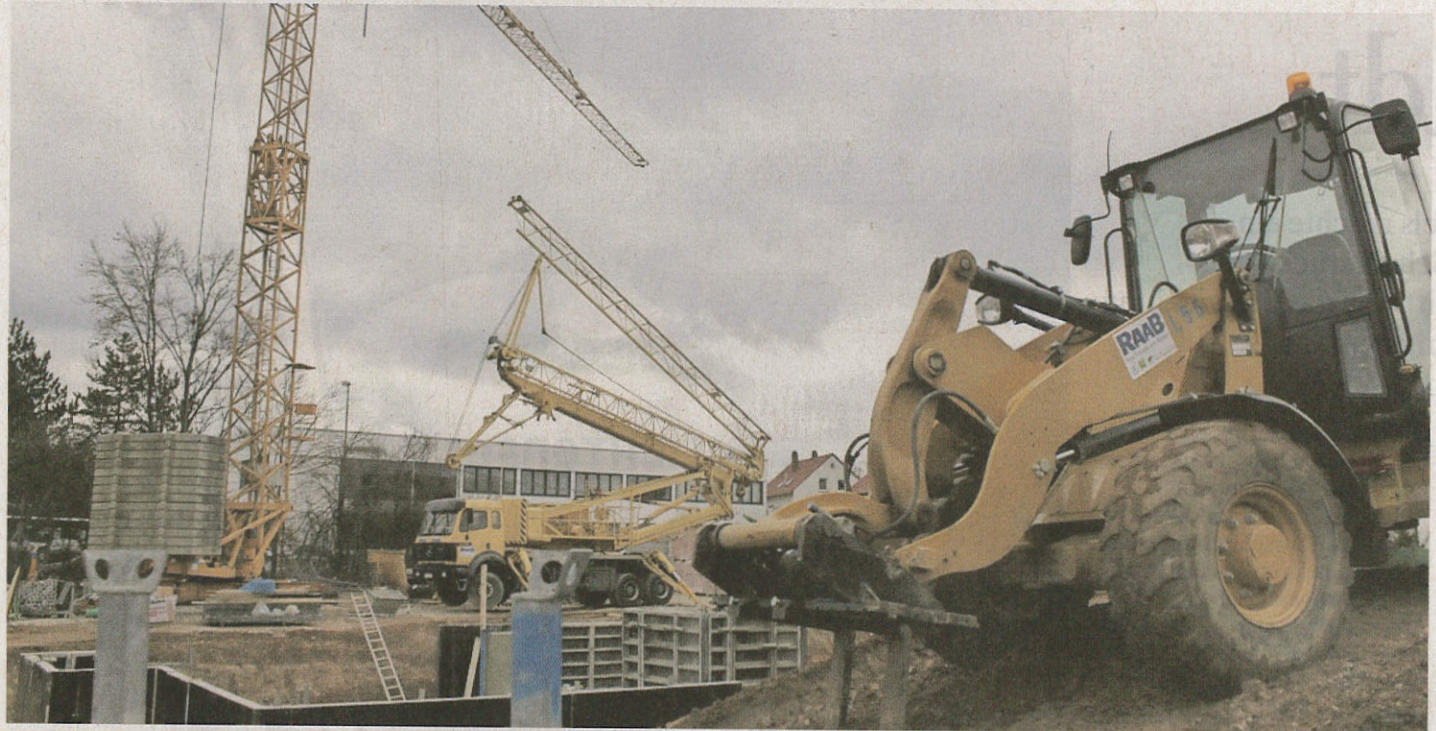
Die schweren Baumaschinen sind schon im Einsatz.
